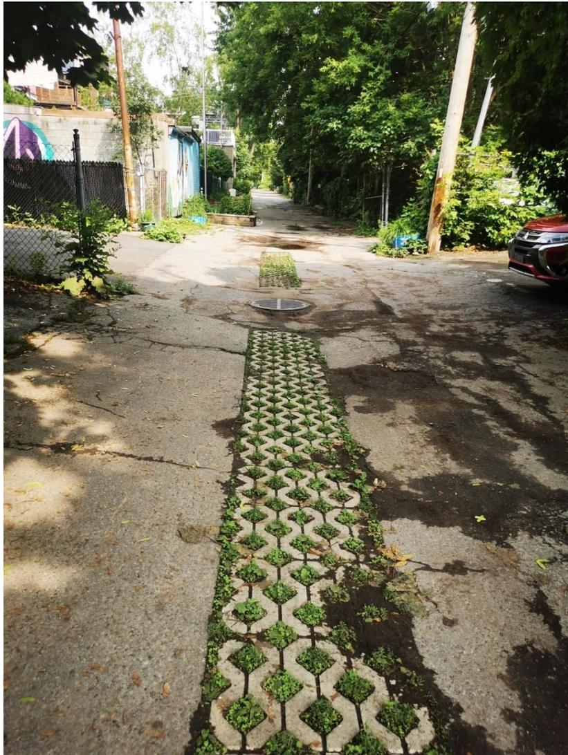
**Figure 19** : Pavés alvéolés servant au drainage des eaux de pluie
